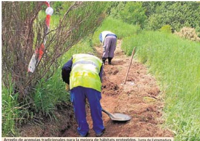
Arreglo de acequias tradicionales para la mejora de hábitats protegidos. Junta de Extremadura
